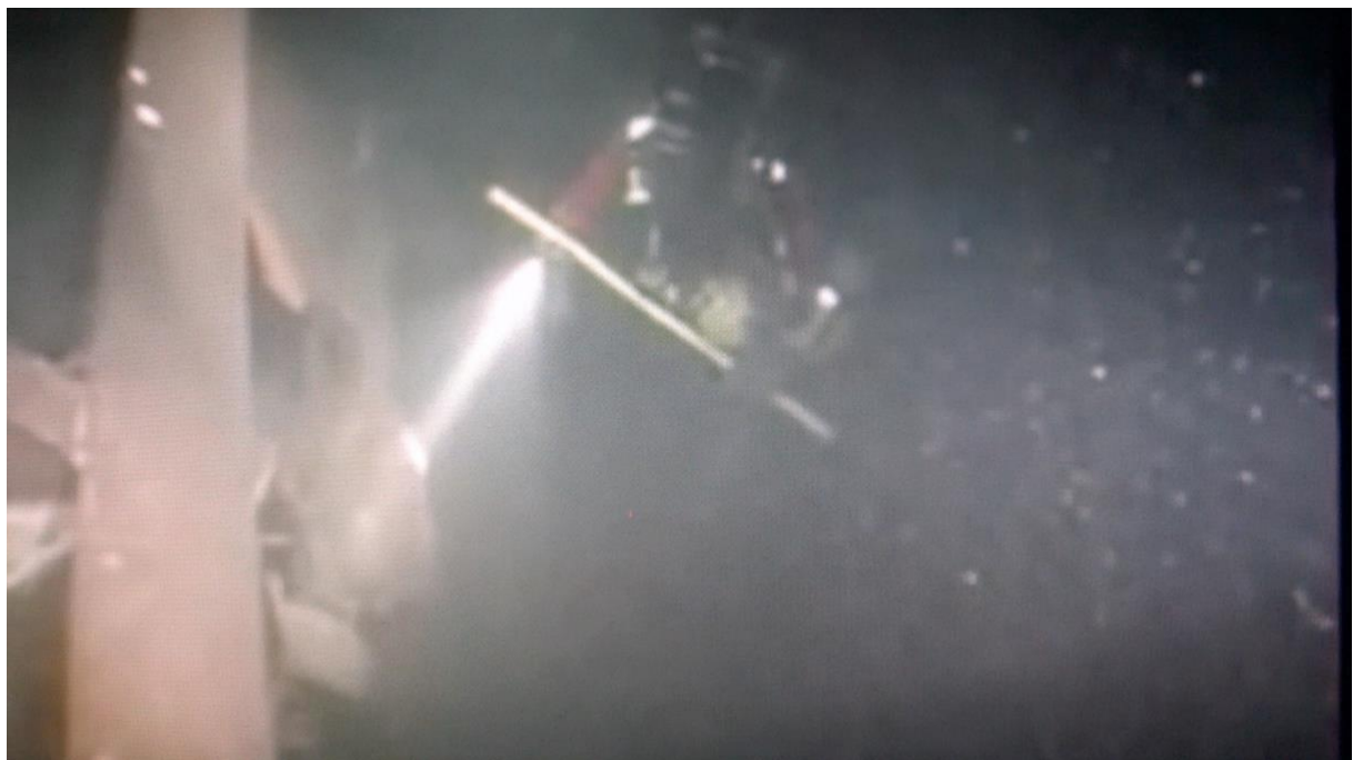
År 2000 undersöker dykare den stora skadan i frontskottet som nu inte är åtkomlig då rampen döljer skadan.
